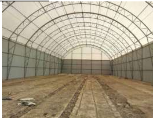
г. Тольятти Производственное помещение 20x100x4м., с кран-балкой г/п 3,2тн.
