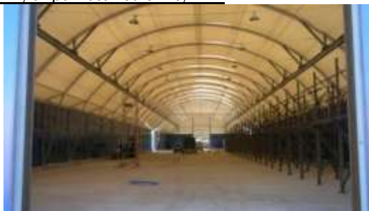
г. Тольятти Производственное помещение 20x100x4м., с кран-балкой г/п 3,2тн.
